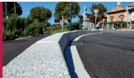
Rond-point Boulevard Pasteur - Courthézon (84) Bordure et caniveaux bouchardés profil pierre Bureau d'études Global Sud
